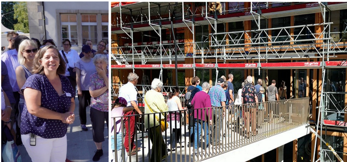
Hereinspaziert! Myriam empfängt eine weitere Gruppe zur Baustellenbesichtigung.
