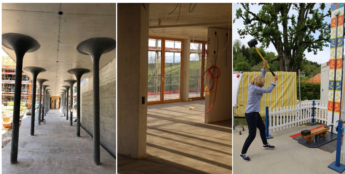
Unter der Brücke entsteht ein Bijou. Vielversprechende Ausblicke.
